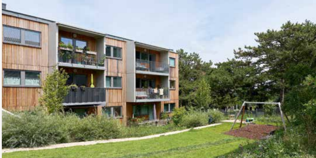
Blick auf die Fassade
